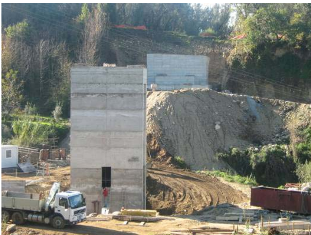
Intervento n°8 pila e spalla sul torrente Iarulli
