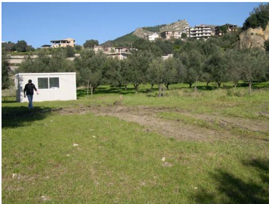
Intervento n°13 lotto E/1° stralcio collegamento Bovalino Bagnara “impianto cantiere”
