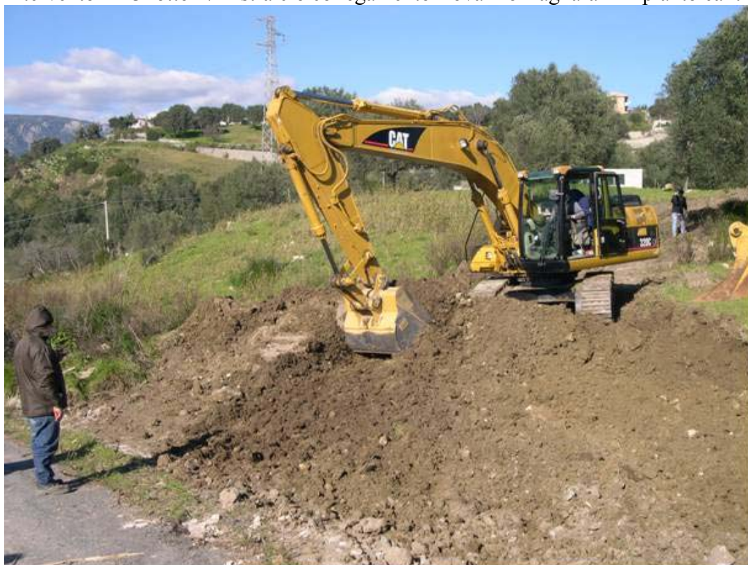
Intervento n°13 lotto E/1° stralcio collegamento Bovalino Bagnara inizio lavori a Careri
