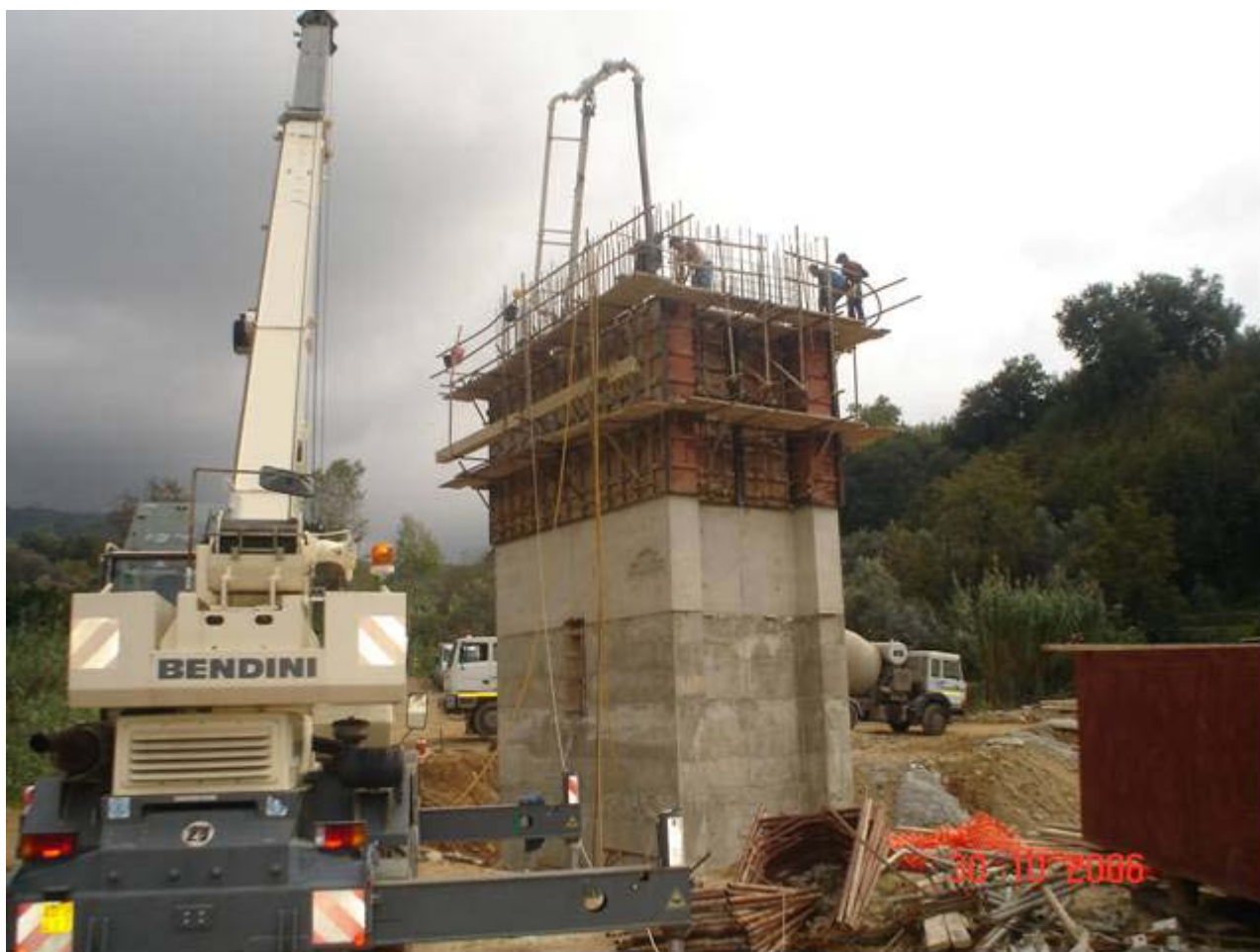
Intervento n°8 pila sul torrente Iarulli
