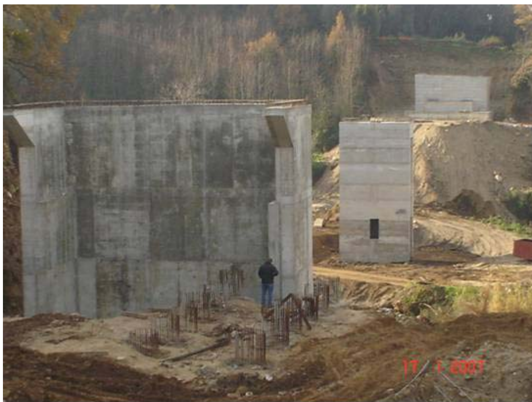
Intervento n°8 pila e spalle sul torrente Iarulli
