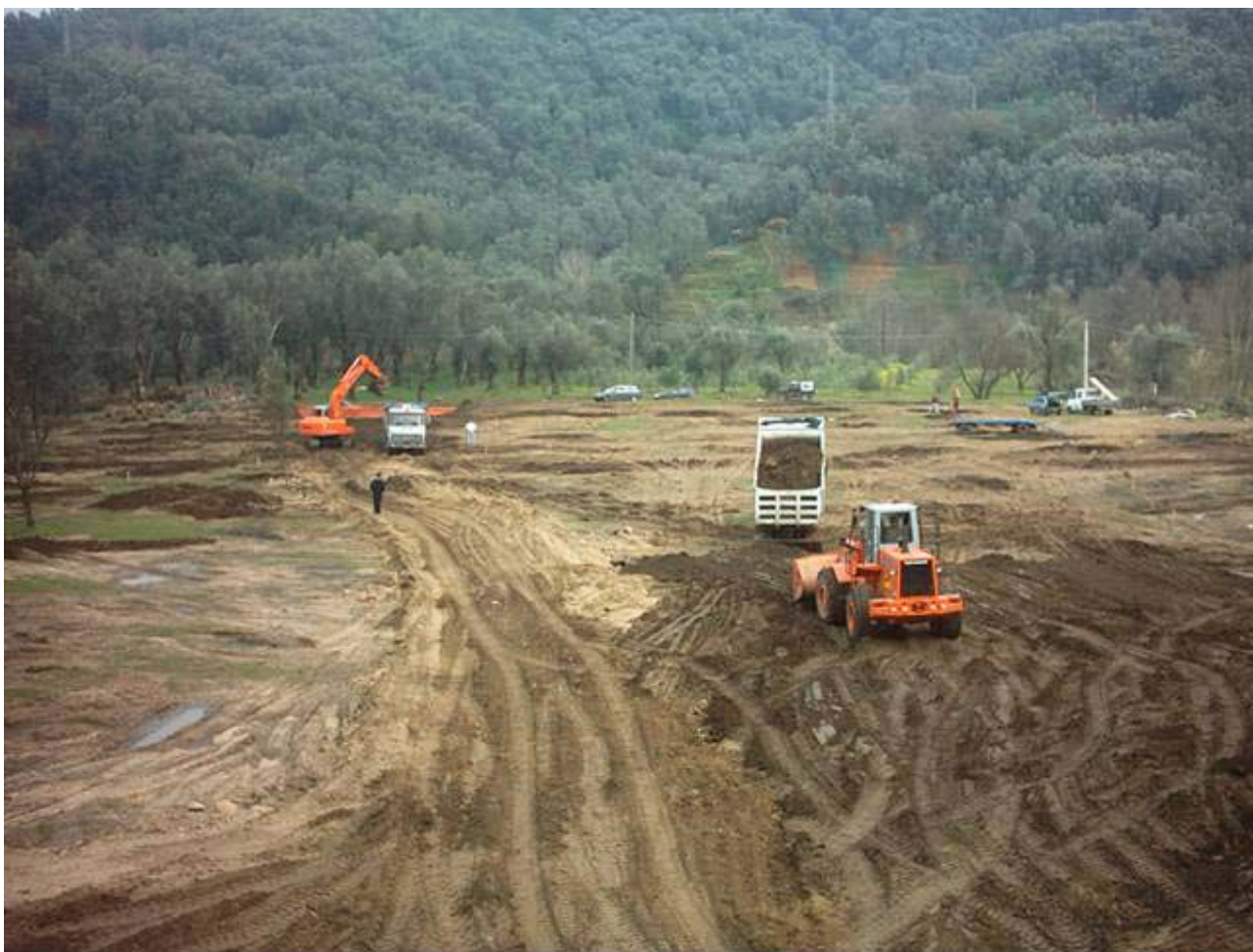
Intervento n°12 – formazione area di cantiere –
